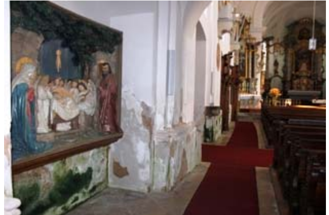
Dringender Sanierungsbedarf: Feuchtschäden im Innenraum der Wallfahrtskirche auf dem Fahrenberg.
