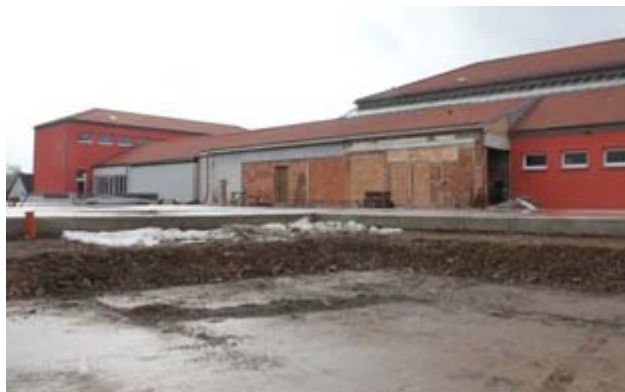
Die Vorbereitungen für die Hochbauarbeiten an der neuen KiTa und Krippe sind abgeschlossen.
