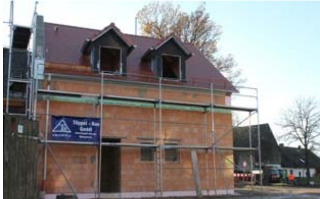
Bauarbeiten schreiten fort: das neue Gerätehaus der FFW Bernrieth.
