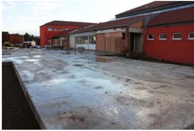
Die schon gegossene Bodenplatte lässt die Grundrisse der neuen Kindereinrichtung (KiTa und Kinderkrippe) erahnen.
