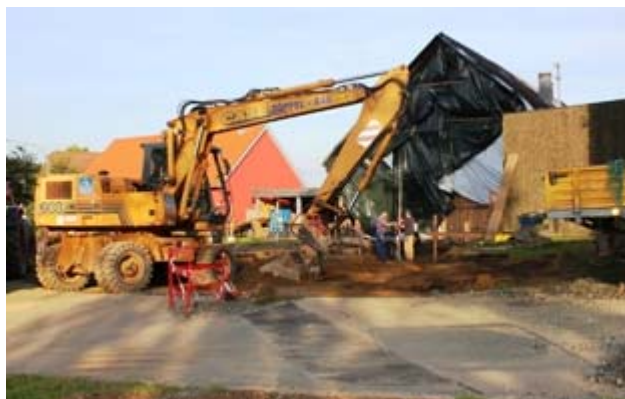
Die Bauarbeiten für das neue Gerätehaus in Oberbernrieth sind mittlerweile in vollem Gange.
