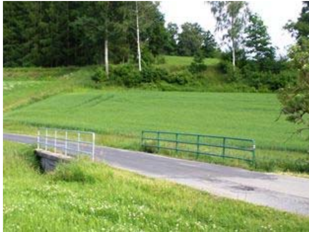
Ein neues Brückengeländer (links) ist schon wieder montiert.
