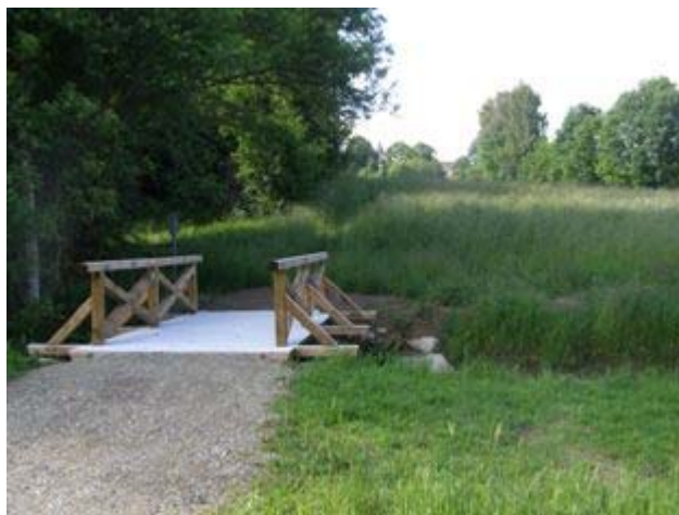
Die neue Holzbrücke über der Luhe wartet auf die richtige Anbindung an den Bockradweg.
