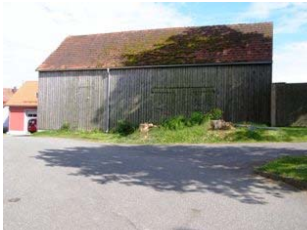
Verzögerungen beim Neubau des Gerätehauses in Oberbernrieth wegen fehlender Planunterlagen.
