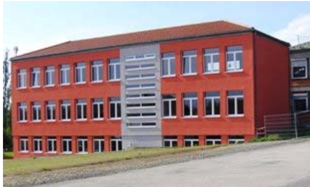
Einweihung der rückgebauten Grundschule am 21. Juli 2012: letzte Arbeiten sind vorher noch notwendig.
