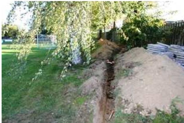
Am Rand des Spielfeldes (im Bild links) wird eine neue Leitung zum Anschluss einer PV-Anlage gelegt.
