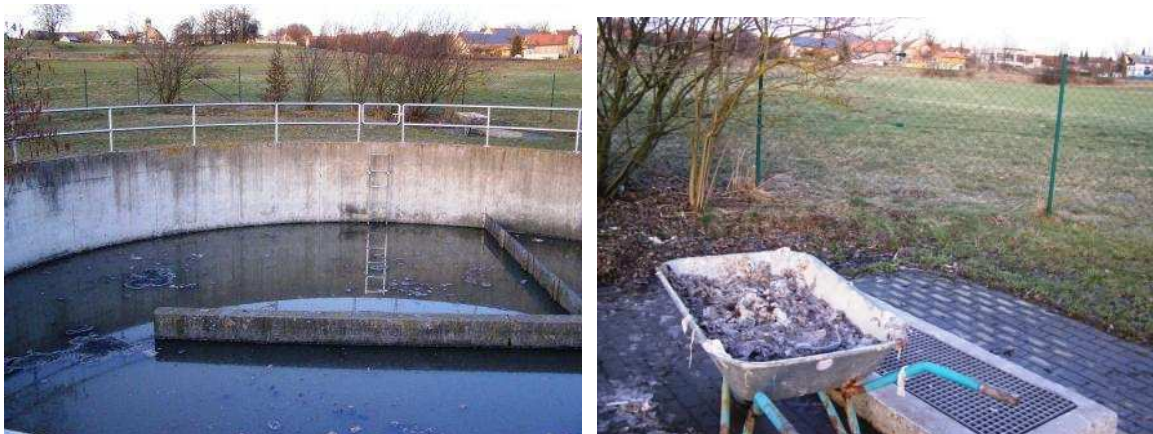
Feststoffe im Vorklärbecken muss der Klärwärter bislang mit einer Harke herausfischen
