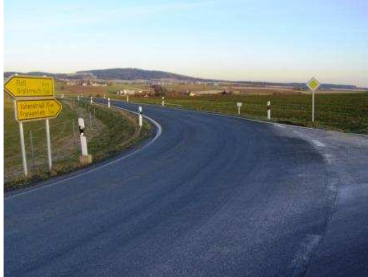
Soll auch mit ausgebaut werden: Staatsstraße von Grafenreuth nach Waldthurn
