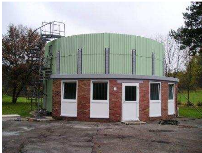
Herausgeputztes Tropfkörperbauwerk – langfristige Genehmigung für Abwasserentsorgung liegt vor
