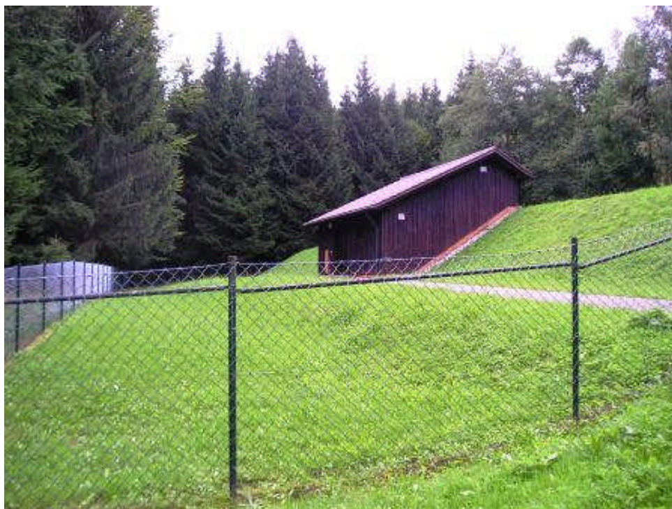
Kontrollen der Wasserversorgung künftig noch effizienter (Hochbehälter am Fahrenberg)
