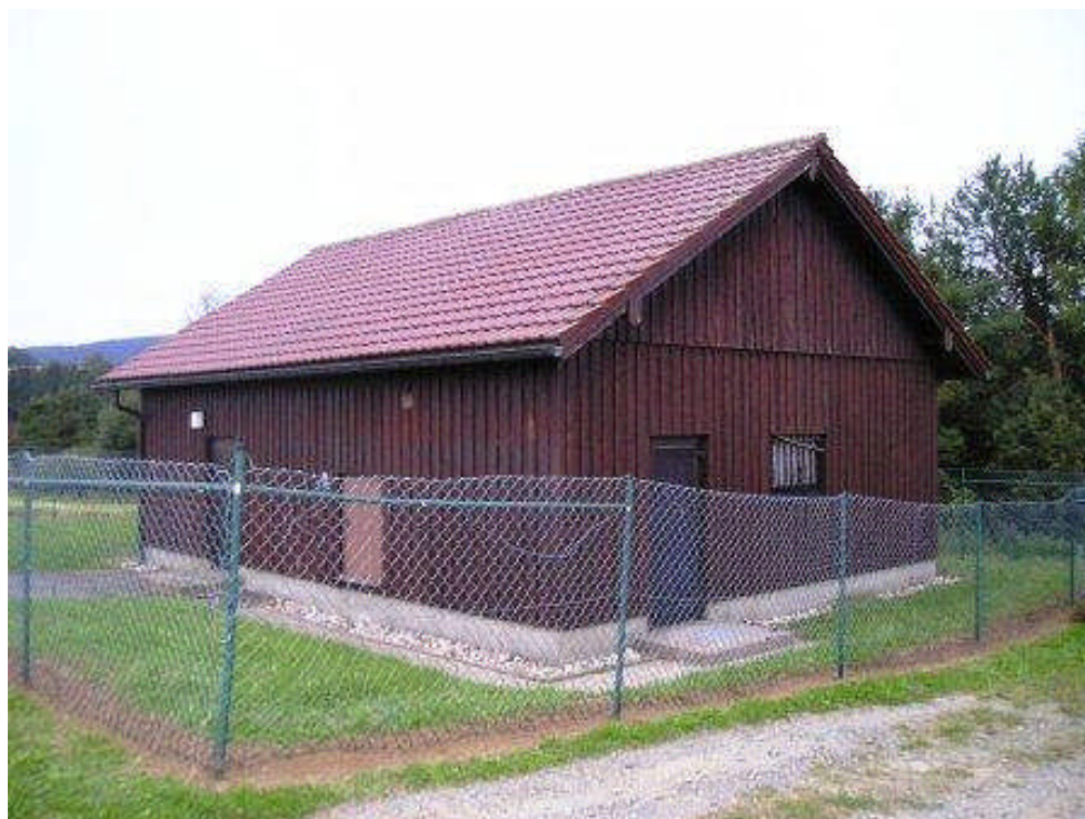
Pumpenhaus und Aufbereitung am Tiefbrunnen – die Technik funktioniert tadellos
