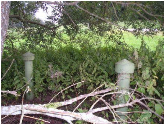
Alter Sammelschacht – Teil der früheren Wasserversorgung
